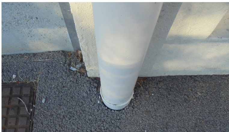
Exemple d'une descente de cheneau hermétique
