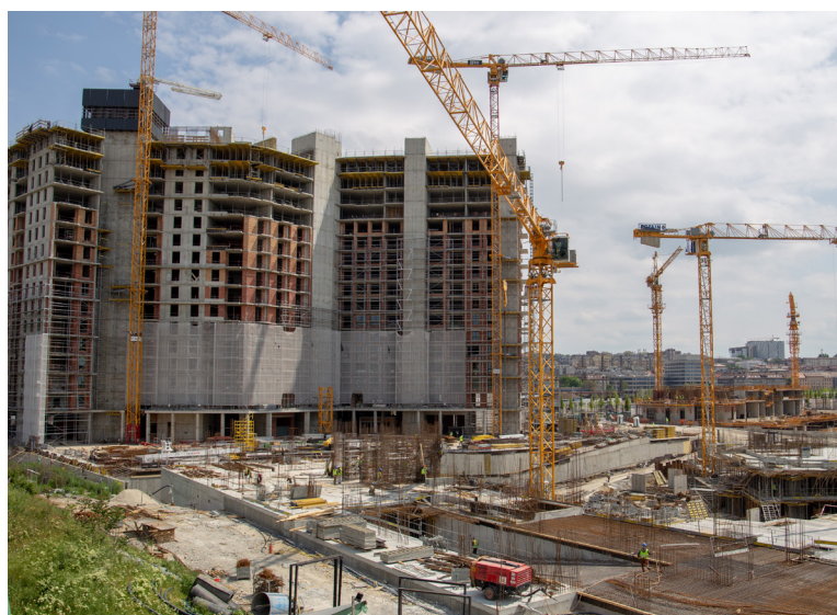
Chantier de construction
